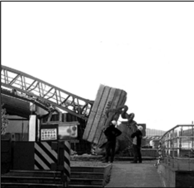
Figura 11. Vista de la base de una grúa torre volcada por efecto del viento
