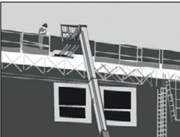
Figura 35. Incorrecta interrupción temporal de la protección colectiva contra caídas sin medidas compensatorias y eficaces de seguridad
