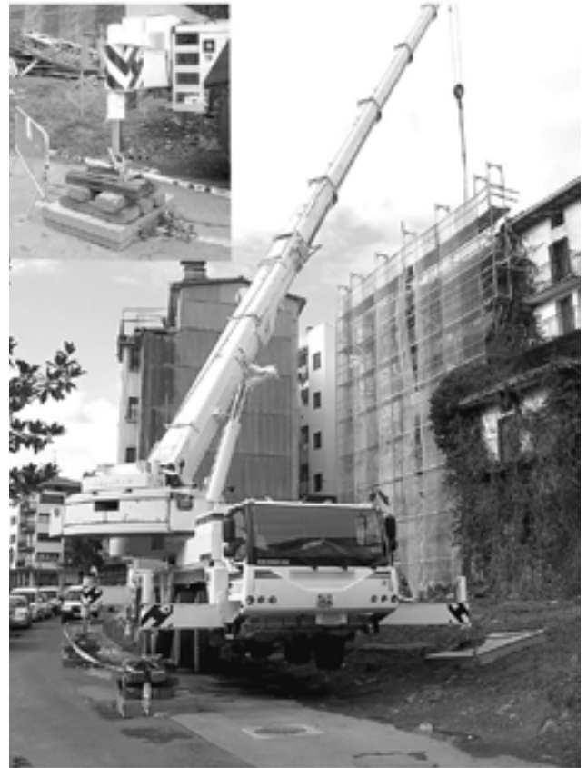
Figura 12. Ejemplo de colocación de elementos suplementarios en los apoyos de los estabilizadores de una grúa móvil
